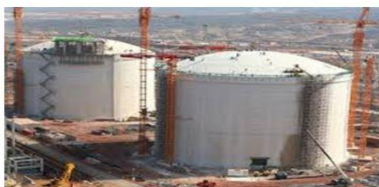
Full Containment LNG Storage Tanks
